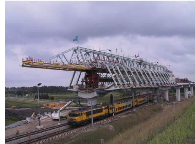
Bouwcombinatie Utrechtboog, Amsterdam, Holland
